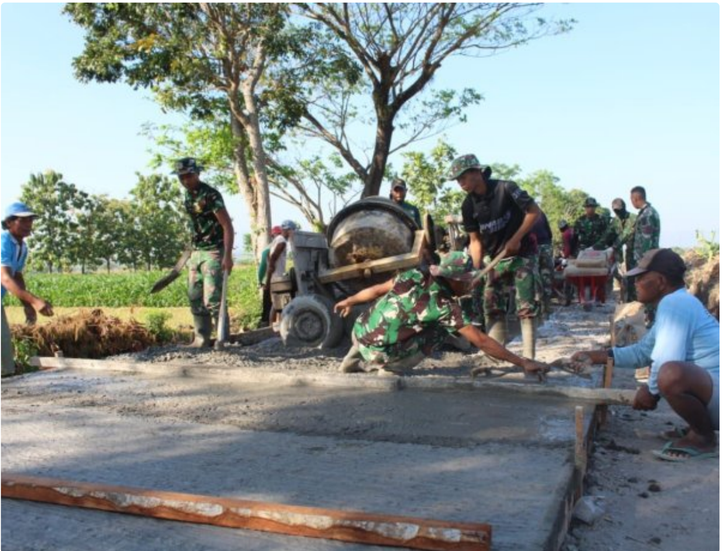
Betonisasi Jalan TMMD Reg 121 Kodim 0723 Klaten Tingkatkan Infrastruktur di Desa Tambong Wetan
